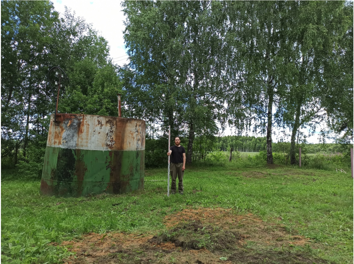
Рис. 22. Калужская область, Куйбышевский район. «Строительство станции водоочистки п. Бетлица Куйбышевского района Калужской области». Участок с к.н. 40:11:171403:2. Вид юго-запада.
