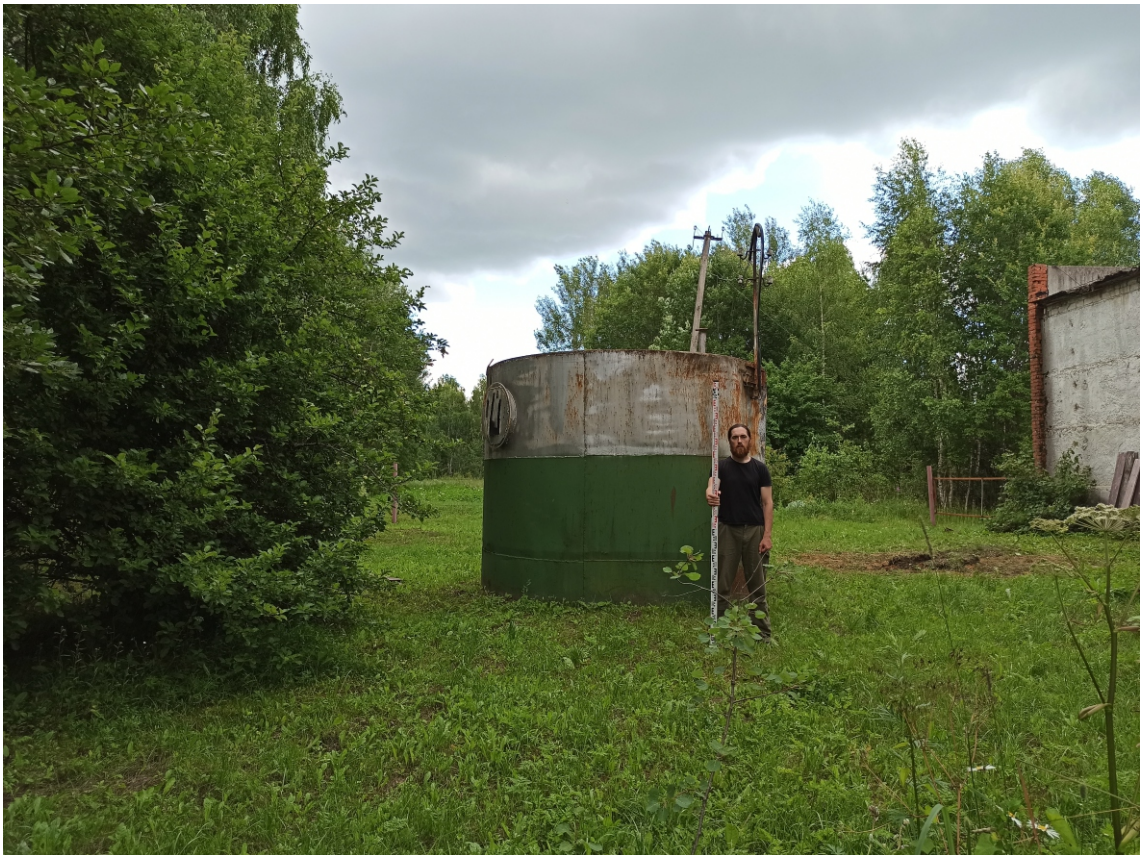
Рис. 25. Калужская область, Куйбышевский район. «Строительство станции водоочистки п. Бетлица Куйбышевского района Калужской области». Участок с к.н. 40:11:171403:2. Вид с северо-запада.
