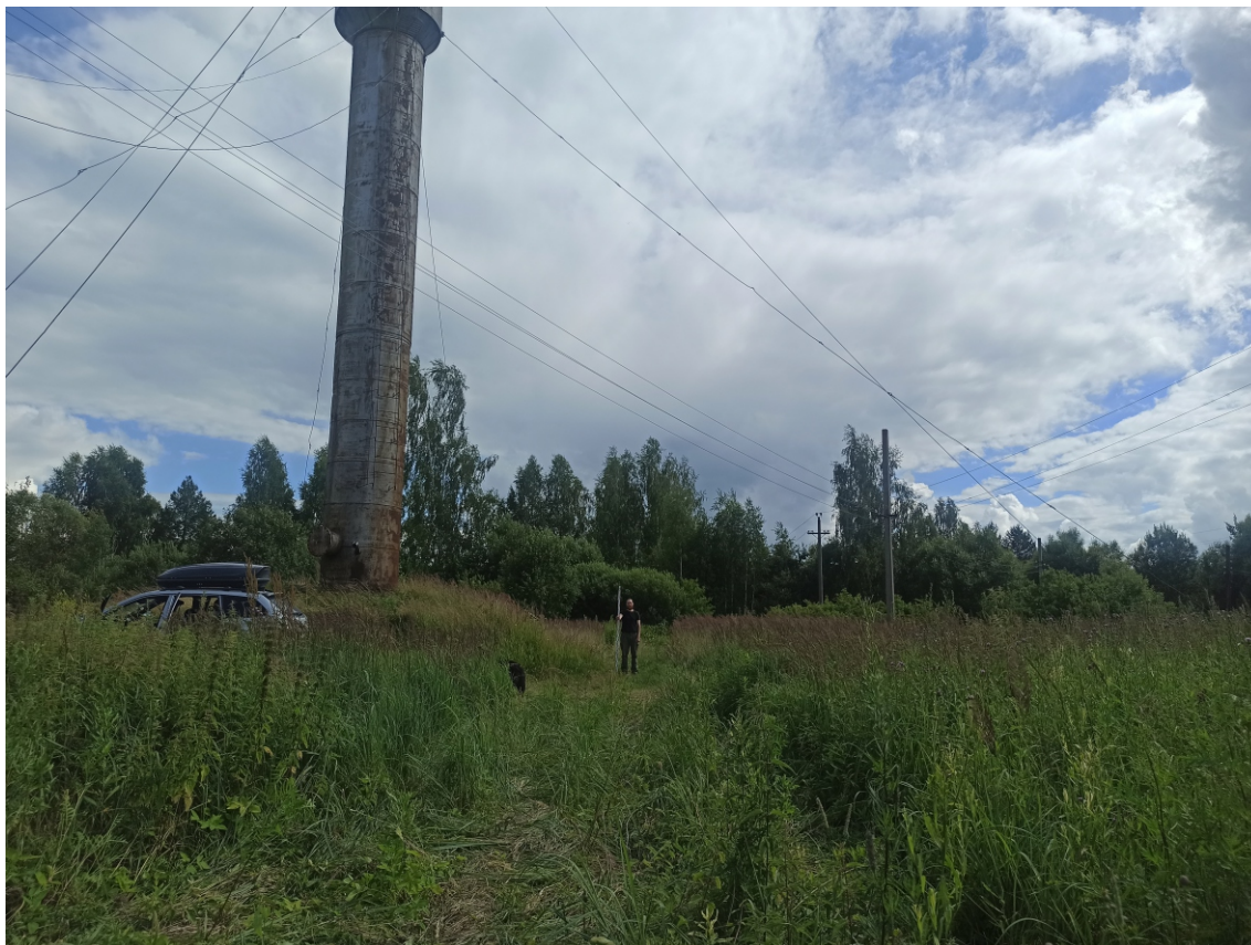
Рис. 6. Калужская область, Куйбышевский район. «Строительство станции водоочистки п. Бетлица Куйбышевского района Калужской области». Участок с к.н. 40:11:170303:3. Северо-западная часть участка. Вид с северо-запада.
