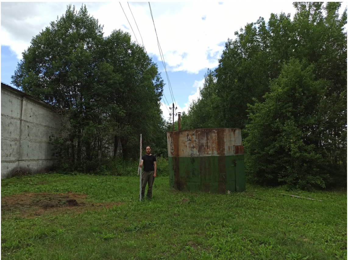
Рис. 23. Калужская область, Куйбышевский район. «Строительство станции водоочистки п. Бетлица Куйбышевского района Калужской области». Участок с к.н. 40:11:171403:2. Вид юго-востока.
