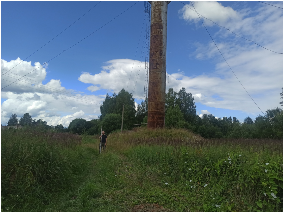
Рис. 13. Калужская область, Куйбышевский район. «Строительство станции водоочистки п. Бетлица Куйбышевского района Калужской области». Участок с к.н. 40:11:170303:3. Северо-западная часть участка. Вид с юго-востока.
